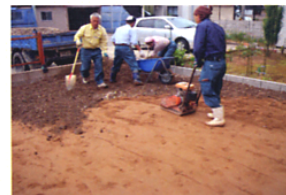
草木の除去や障害物を取り除き 施工場所の不陸整正及び転圧を行います。
