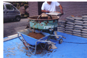
優土〔優土Ⅱ〕+瓦材+水をミキサーに 投入し十分練り混ぜる。
