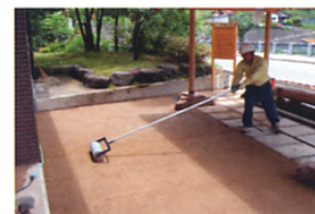
練り混ぜた優土をレキ等で敷き均し、手押しローラー等で十分に締め固める。 ※ 締め固め後は補足材やコテ等を使用し補修を行わない様にする。
