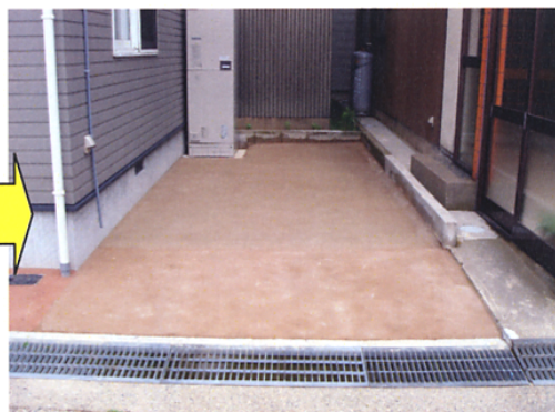
草木の除去や障害物を取り除き 施工場所の不陸整正及び転圧を行います。
