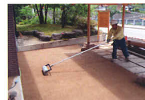
練り混ぜた優土をレキ等で敷き均し、手押しローラー等で十分に締め固めをする。 ※ 締め固め後は補足材やコテ等を使用し補修を行わない様にする。
