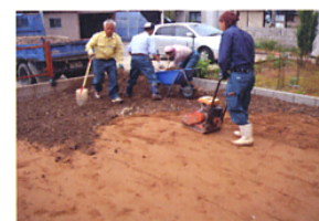
草木の除去や障害物を取り除き 施工場所の不陸整正及び転圧を行います。
