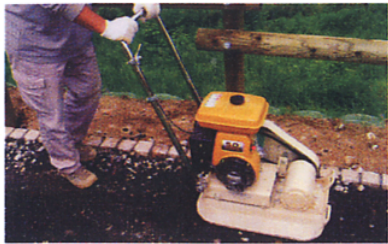
①路盤が動かないようよく締め固め、路盤に水を十分に撒く。
