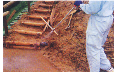
③表面が湿る程度に一次散水（霧の細かい散水）を行う。
